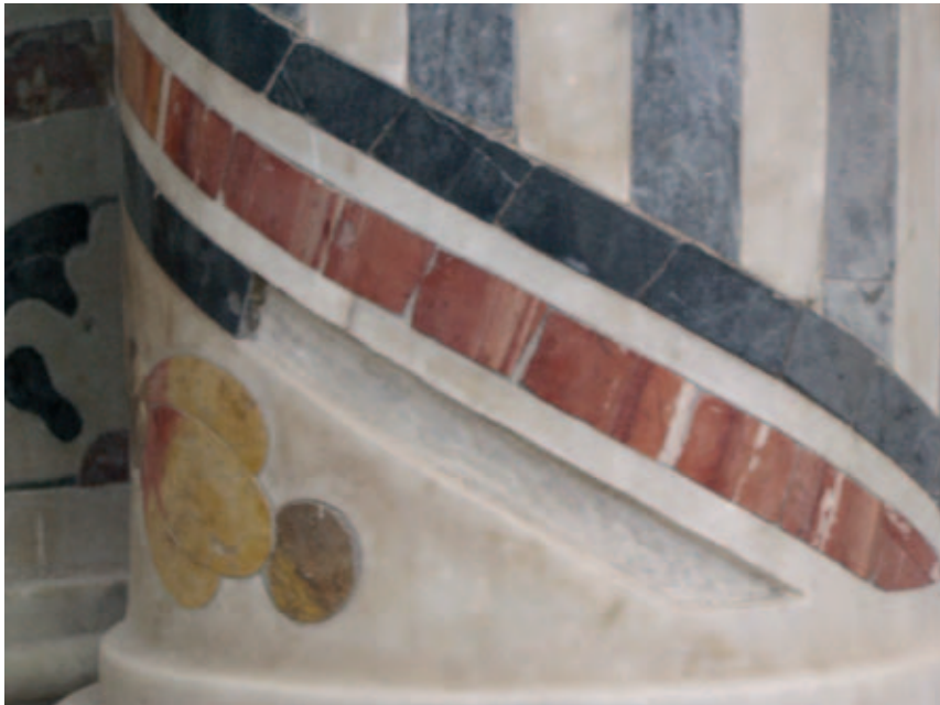
Fig. 6.2. Nicotera. Chiesa di San Giuseppe. Altare maggiore. Dettaglio dell'applicazione della tecnica dell'intarsio marmoreo.
